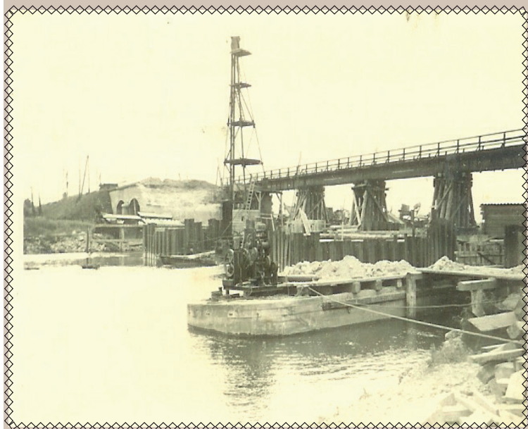
Reconstruction du pont SNCF pendant la seconde guerre mondiale
