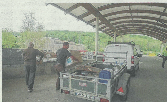
La mise aux normes des déchetteries de l'agglomération va se poursuivre.
