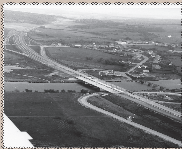
Le pont actuel lors de sa construction
